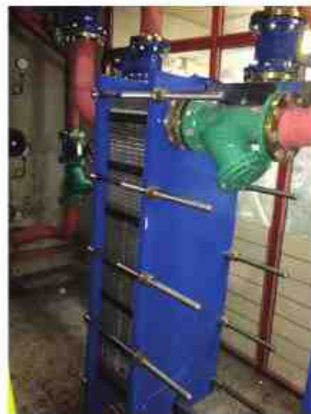
بانک ملت ( فشار شکن بین چیلر و فن کویل ها )
